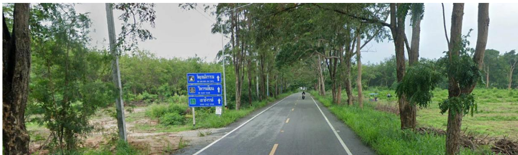
รูปที่ 5-30 ทางหลวงชนบท ขบ.3002
