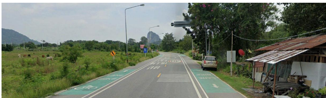
รูปที่ 5-31 ทางหลวงชนบท ขบ.5010
