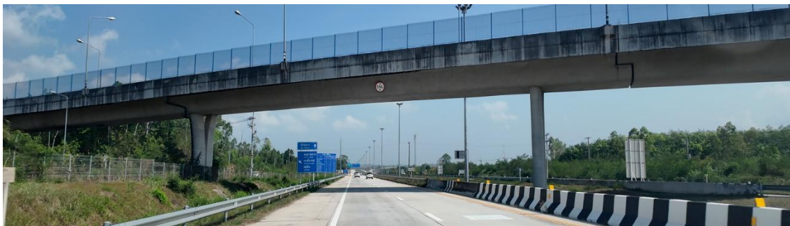
รูปที่ 5-7 สภาพปัจจุบันทางหลวงพิเศษระหว่างเมืองหมายเลข 7 ช่วงประมาณ กม.142+500
