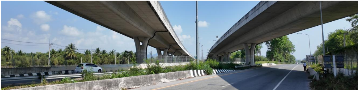
ทางหลวงหมายเลข 331 ช่วงลอดใต้ทางหลวงพิเศษระหว่างเมืองหมายเลข 7 มุมมองตามแนวทางหลวงพิเศษระหว่างเมืองหมายเลข 7
