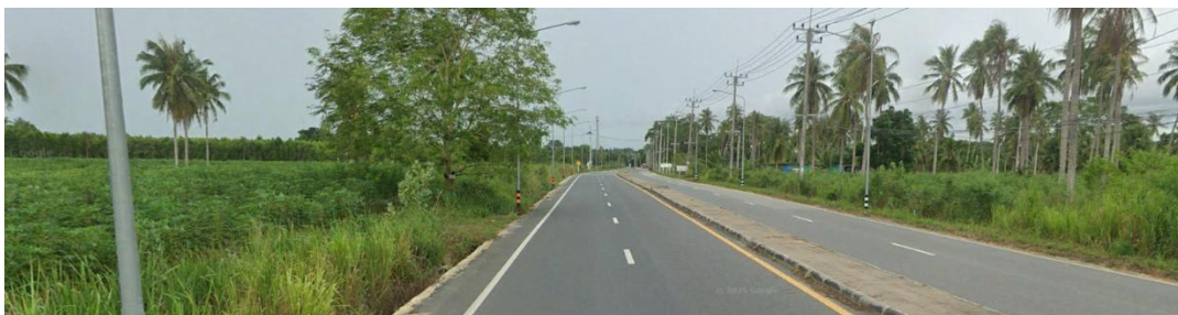
รูปที่ 5-29 ทางหลวงชนบท ขบ.2081
