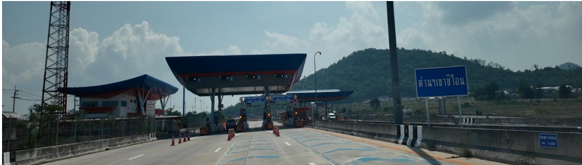
บริเวณด่านเก็บค่าผ่านทางเขาชีโอน
