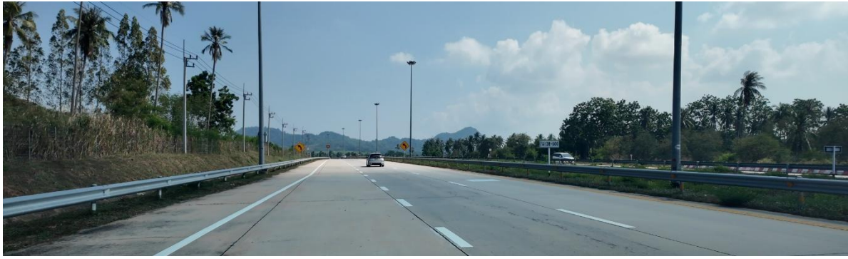
รูปที่ 5-2 สภาพปัจจุบันทางหลวงพิเศษระหว่างเมืองหมายเลข 7 ช่วงประมาณ กม.138+600
