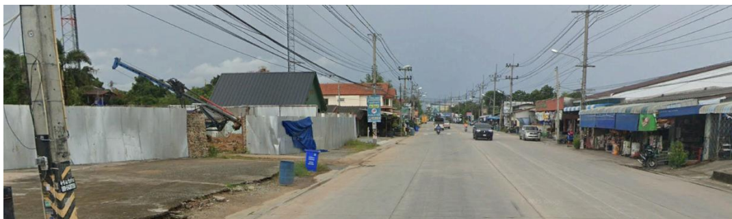
รูปที่ 5-28 ทางหลวงชนบท ขบ.1096
