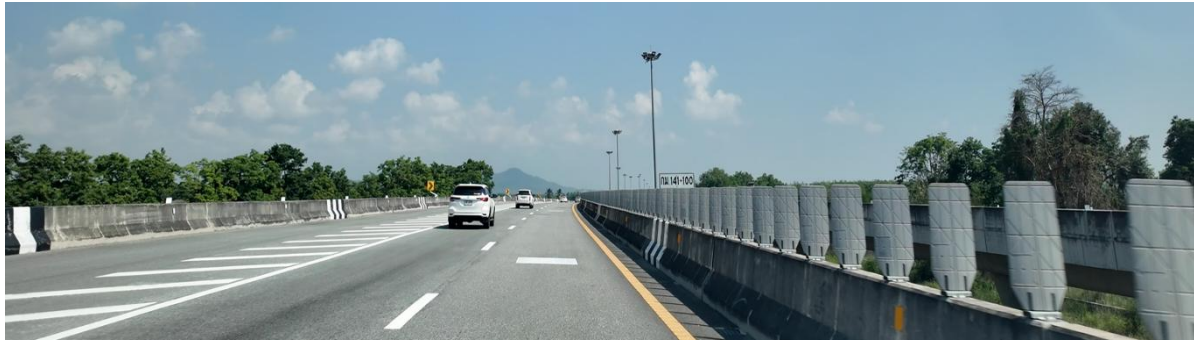
รูปที่ 5-5 สภาพปัจจุบันทางหลวงพิเศษระหว่างเมืองหมายเลข 7 ช่วงประมาณ กม.141+175
