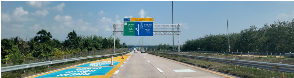
รูปที่ 5-6 สภาพปัจจุบันทางหลวงพิเศษระหว่างเมืองหมายเลข 7 ช่วงประมาณ กม.141+700
