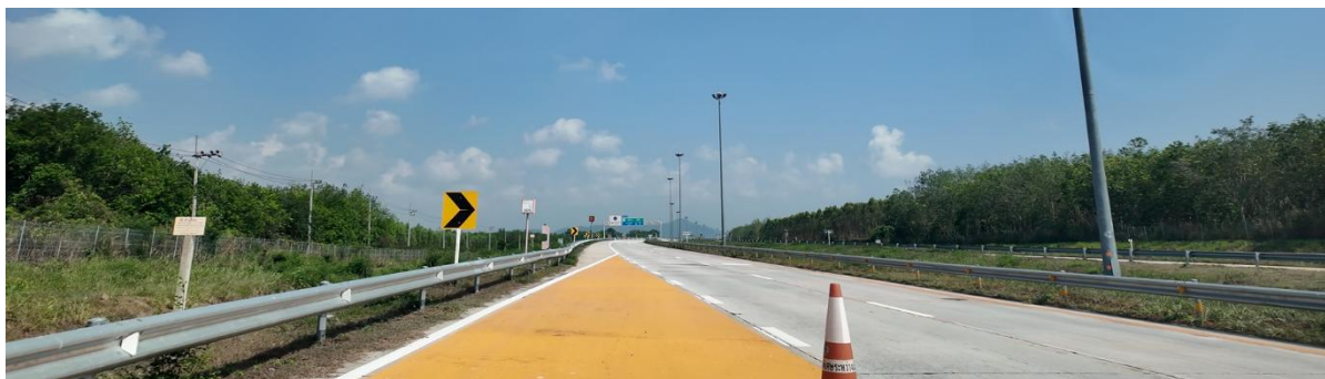
รูปที่ 5-4 สภาพปัจจุบันทางหลวงพิเศษระหว่างเมืองหมายเลข 7 ช่วงประมาณ กม.140+600
