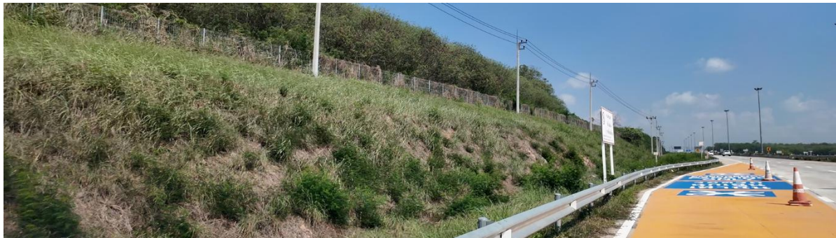
รูปที่ 5-3 สภาพปัจจุบันทางหลวงพิเศษระหว่างเมืองหมายเลข 7 ช่วงประมาณ กม.139+600
