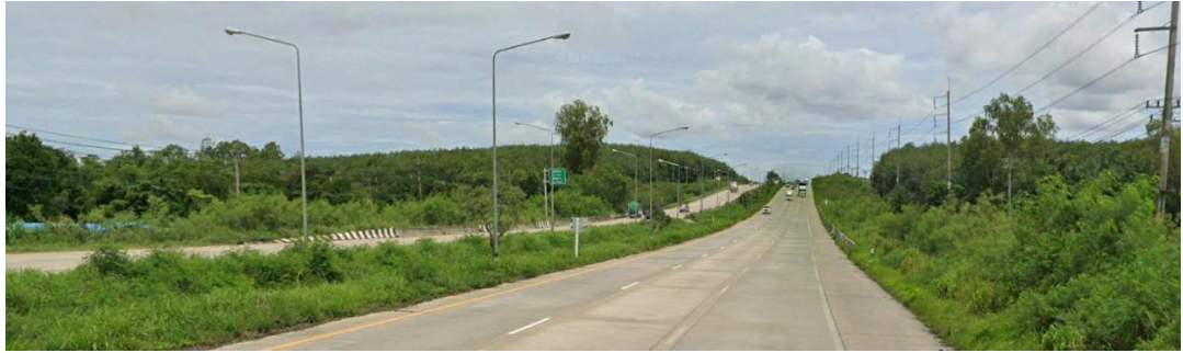
รูปที่ 5-21 ทางหลวงแผ่นดินหมายเลข 36
