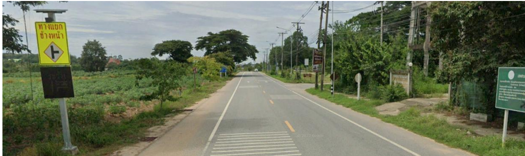
รูปที่ 5-27 ทางหลวงชนบท ขบ.1063
