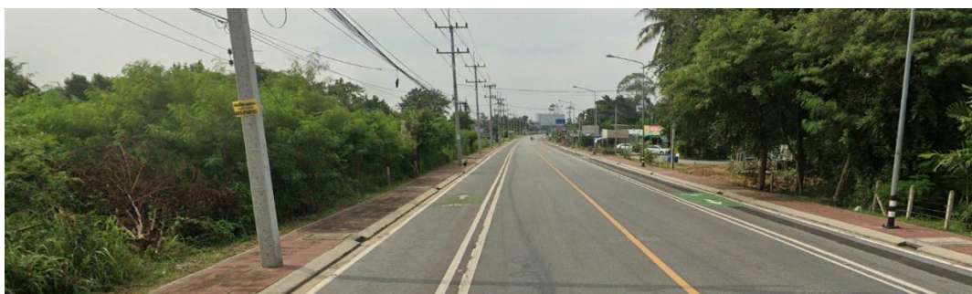
รูปที่ 5-25 ทางหลวงชนบท ชบ.1003
